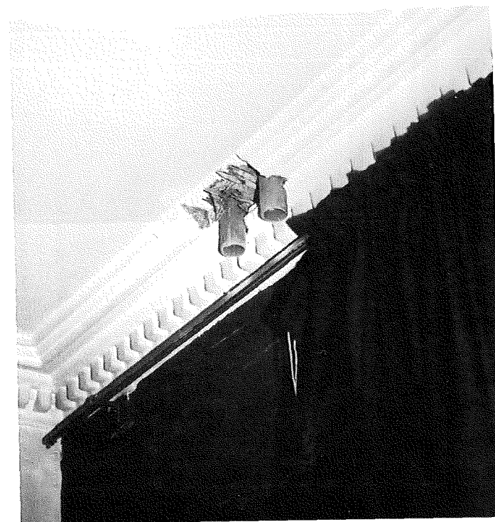
Figur 18. Gennemføring af varmerør i etageadskillelse. Varmerørene blev placeret så tæt ved facaden som muligt, hvilket medførte, at rørene kom til at beskadige stukloftet.
